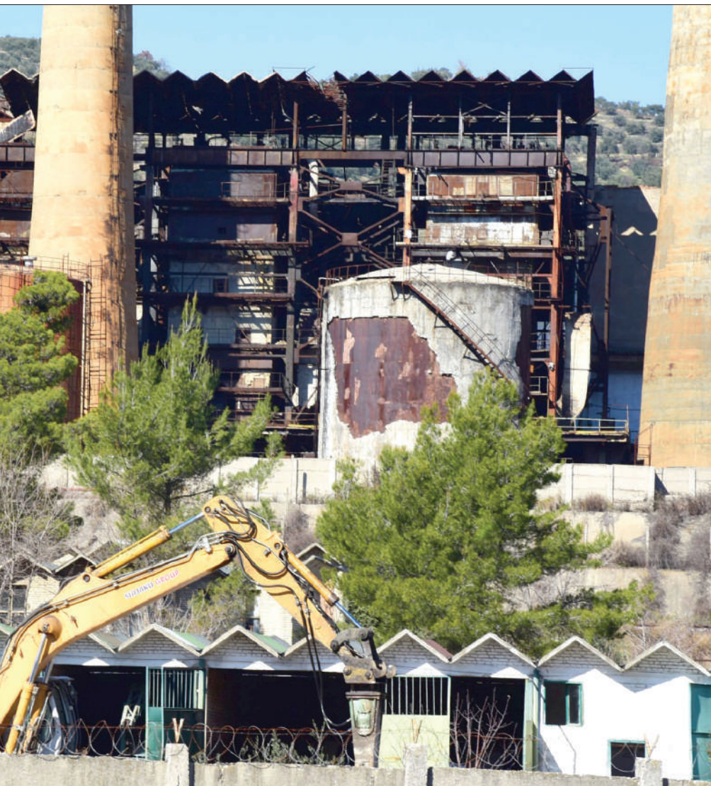
Makineritë e rënda të kompanisë "Shijaku" po çmontojnë hekurin e rafinerisë. Kompania premtom të ndërtojë një park fotovoltaik në vend të rafinerisë. Foto: Nensi Bogdani/ BIRN
